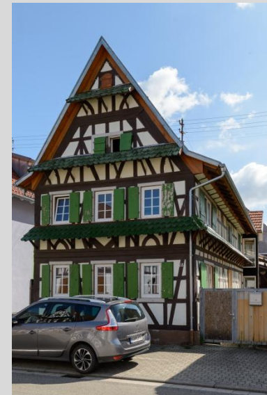
Wohnhaus, Ansicht von Westen.
