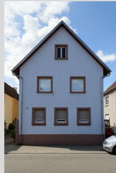
Haus Nr. 39, Ansicht von Osten.
