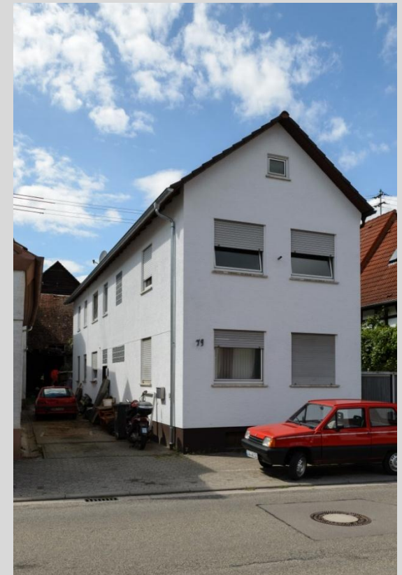
Wohnhaus, Ansicht von Osten.
