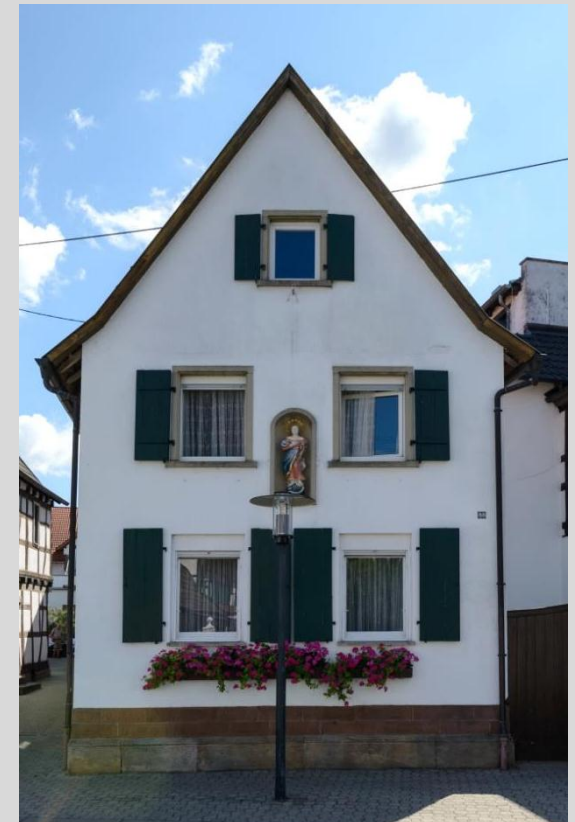
Wohnhaus, Ansicht von Westen.
