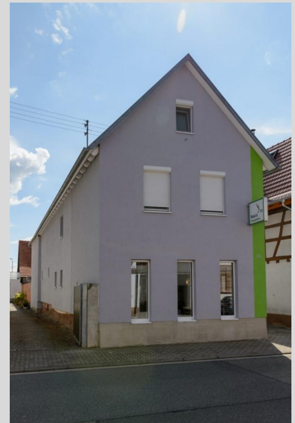
Wohnhaus, Ansicht von Westen.
