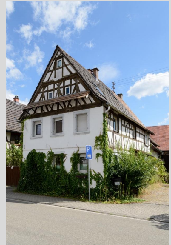
Wohnhaus, Ansicht von Westen.
