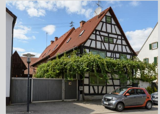
Wohnhaus, Ansicht von Osten.
