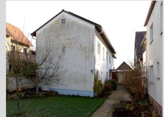
Wohnhaus, Ansicht von Westen.
