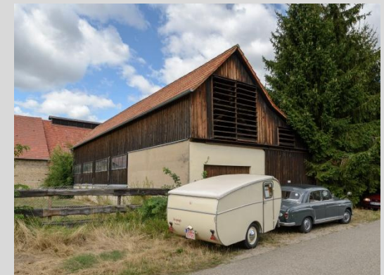
Wirtschaftsgebäude, Ansicht vom Kapellenweg.
