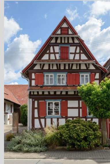
Wohnhaus, Ansicht von Osten.
