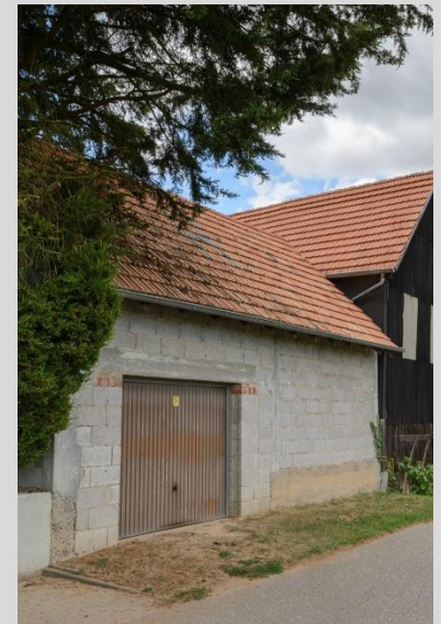
Nebengebäude (Garage), Ansicht vom Kapellenweg.
