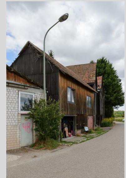
Nebengebäude, Ansicht vom Kapellenweg.
