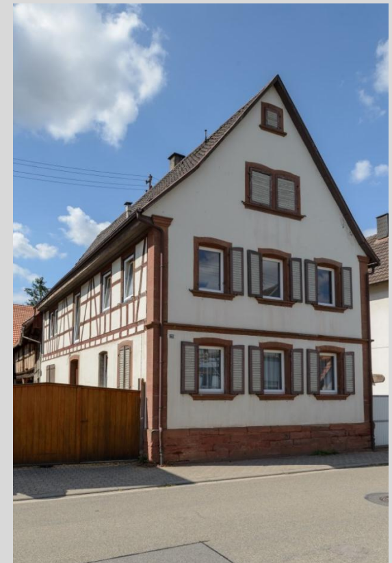
Wohnhaus, Ansicht von Westen.
