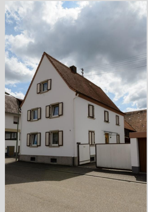
Wohnhaus mit Teilansicht der Hofsituation.
