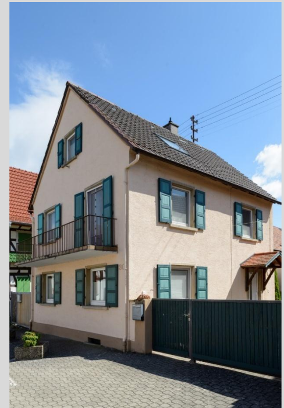
Wohnhaus, Ansicht von Westen.
