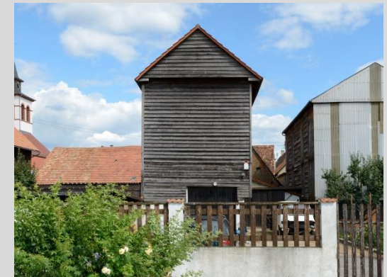
Tabakschuppen, Ansicht von der Friedhofstraße.
