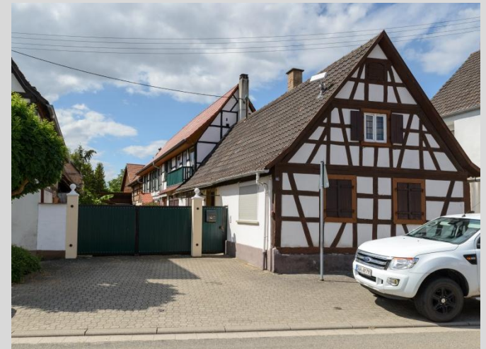
Wohnhaus, Ansicht von Südosten.
