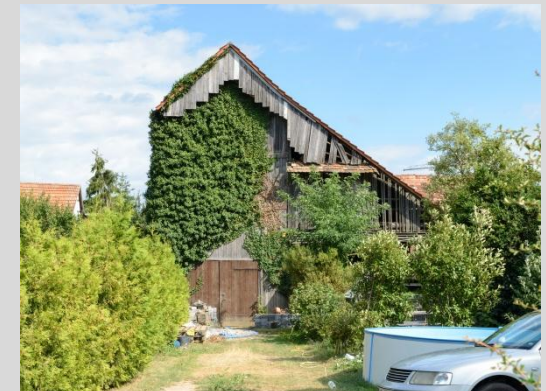
Wirtschaftsgebäude, Ansicht von der Friedhofstraße.
