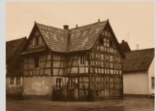
Vorgängerbau, Ansicht vor 1967.
