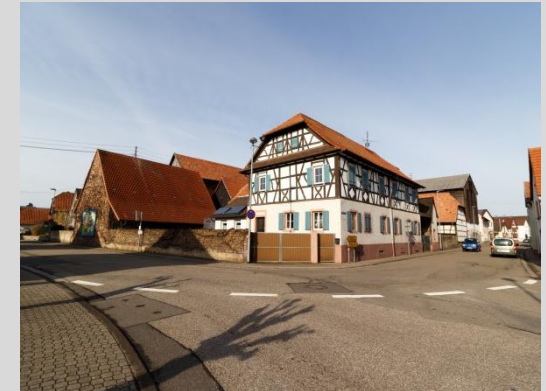
Gesamtanlage am Kurvenverlauf der Hauptstraße.
