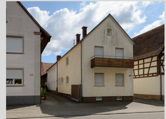
Wohnhaus, Ansicht von Westen.
