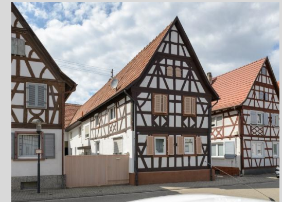
Wohnhaus, Ansicht von Osten.
