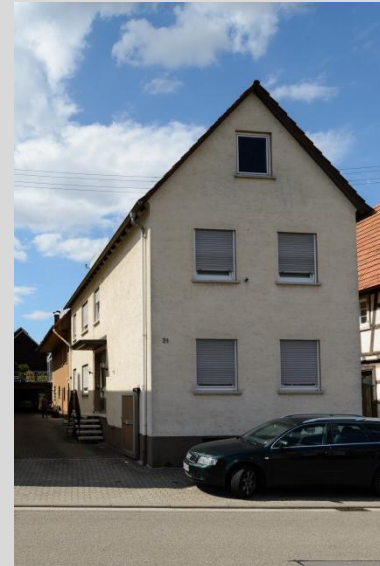
Wohnhaus, Ansicht von Osten.
