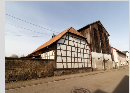
Wirtschaftsgebäude und Tabakschuppen, Ansicht von der Hauptstraße.
