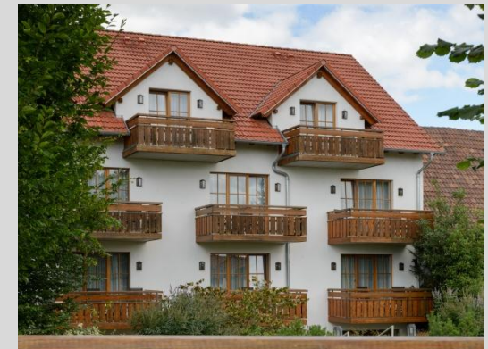
Hotelanbau, Ansicht vom Kapellenweg.
