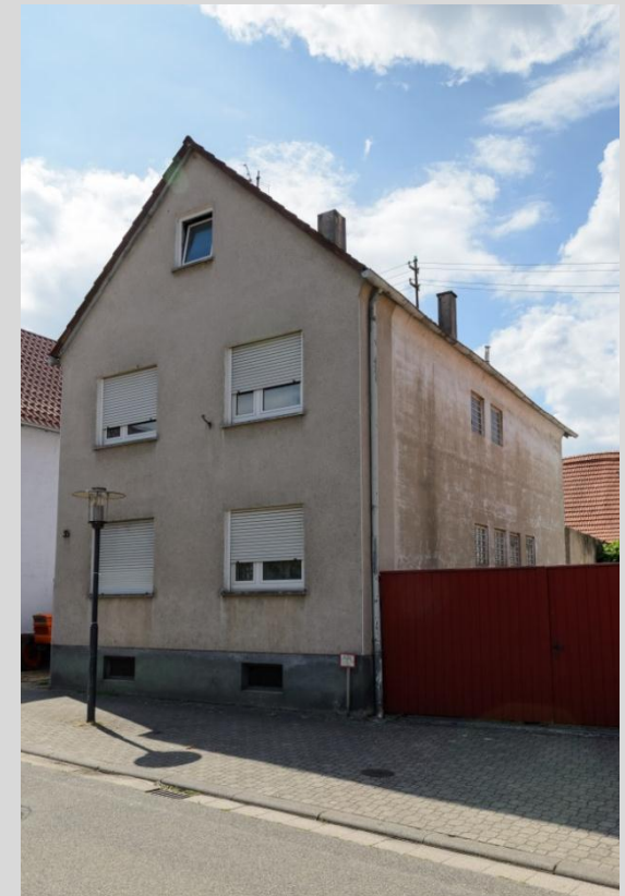
Wohnhaus, Ansicht von Osten.
