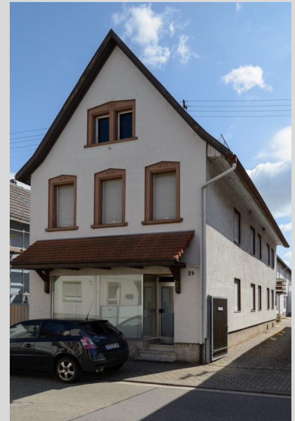
Wohnhaus, Ansicht von Westen.
