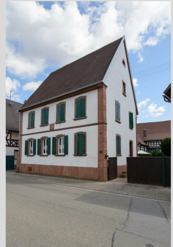
Wohnhaus mit Ansicht der Hofsituation.
