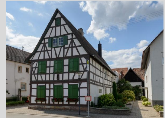
Wohnhaus, Ansicht von Westen.
