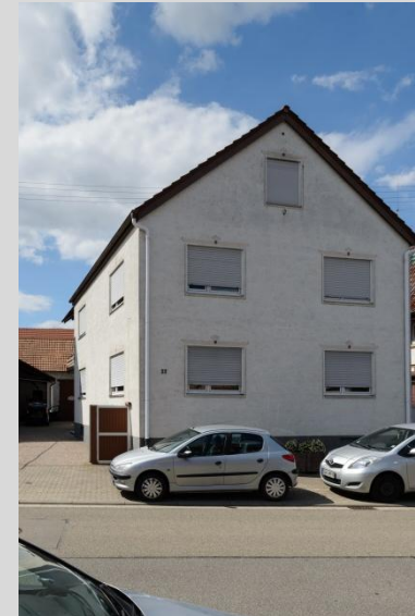
Wohnhaus, Ansicht von Nordosten.
