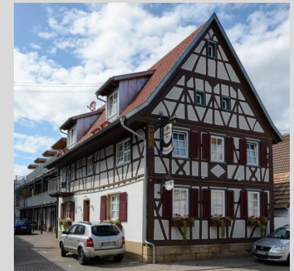
Wohnhaus, Ansicht von Westen.
