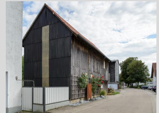
Tabakschuppen, Ansicht von der Friedhofstraße.
