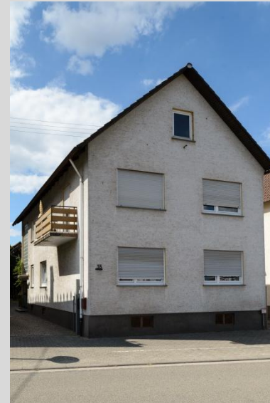
Wohnhaus, Ansicht von Osten.
