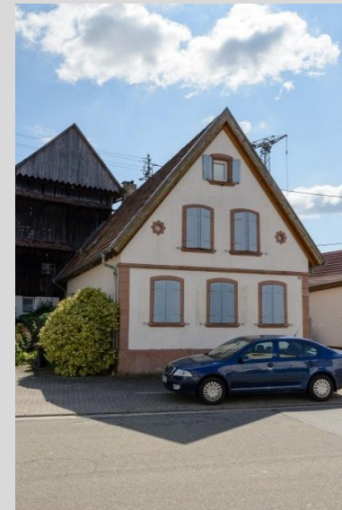
Wohnhaus, Ansicht von Westen.
