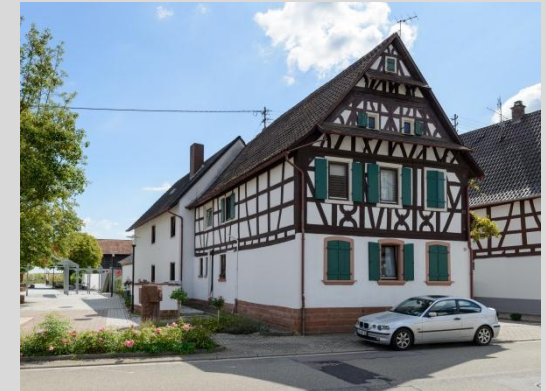
Wohnhaus, Ansicht von Westen.
