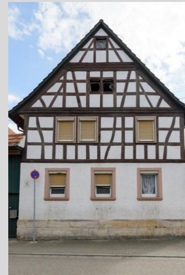
Wohnhaus, Ansicht von Norden.
