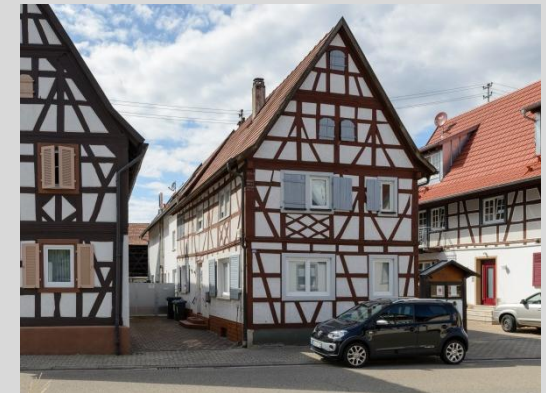
Wohnhaus, Ansicht von Osten.
