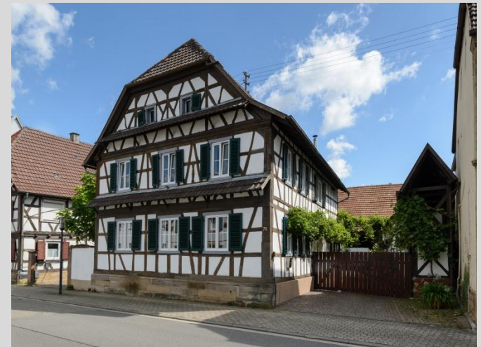
Wohnhaus, Ansicht von Westen.
