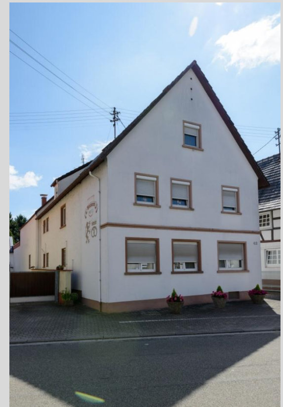
Wohnhaus, Ansicht von Osten.
