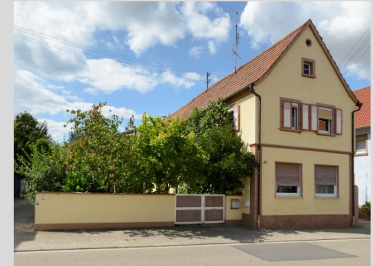
Wohnhaus, Ansicht von Osten.
