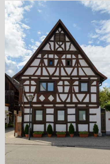
Wohnhaus Nr. 99, Ansicht von Osten.
