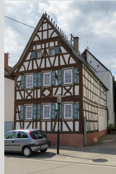
Wohnhaus, Ansicht von Osten.
