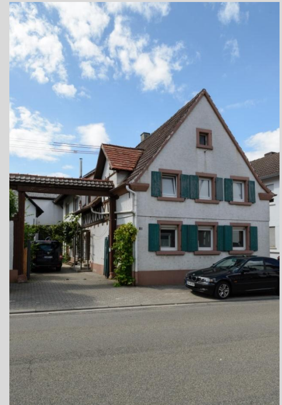
Wohnhaus, Ansicht von Osten.
