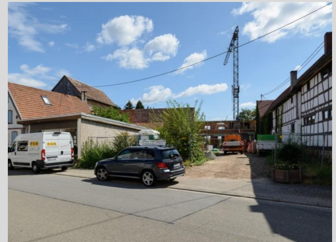
Baustelle, Zustand Sommer 2018.
