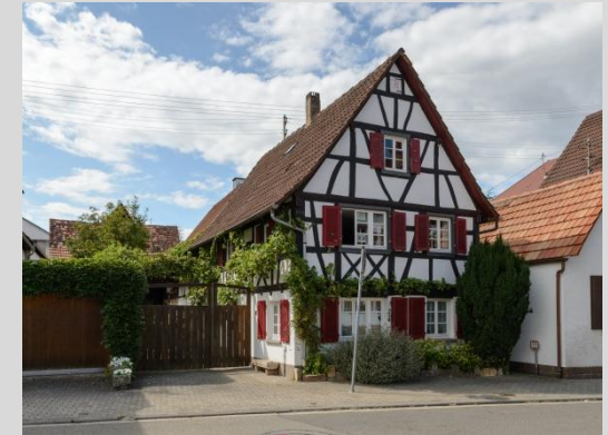
Wohnhaus, Ansicht von Osten.
