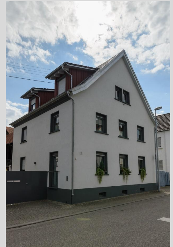
Wohnhaus, Ansicht von Nordosten.
