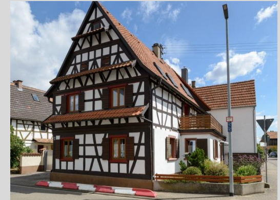
Haus Nr. 114, Ansicht von Westen.
