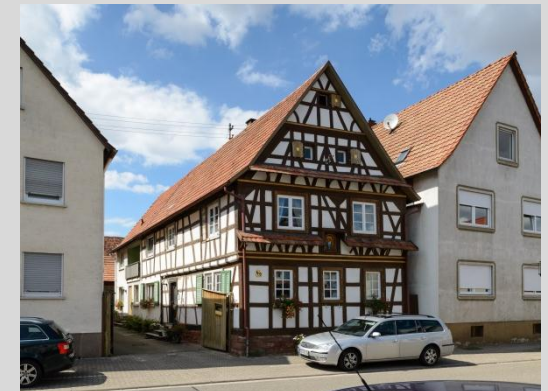
Wohnhaus, Ansicht von Osten.
