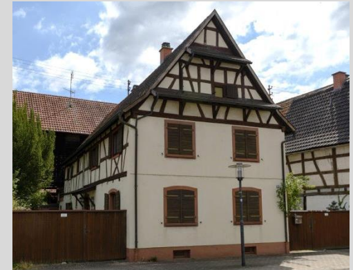
Wohnhaus, Ansicht von Westen.
