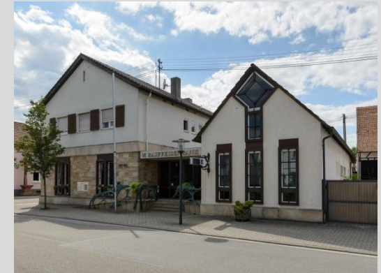
Raiffeisenbank, Ansicht von Osten.
