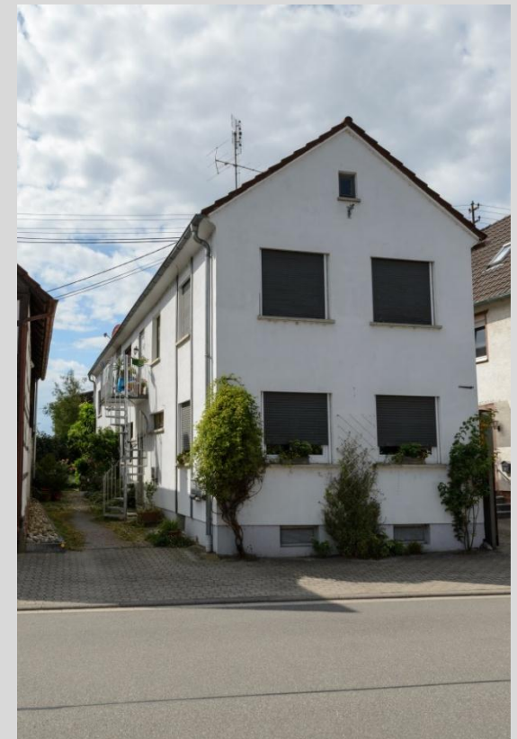
Wohnhaus, Ansicht von Westen.
