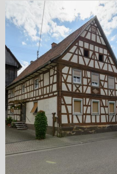
Wohnhaus, Ansicht von Nordosten.
