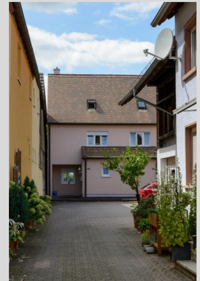
Häuser Nr. 39A & 39B, Hofansicht.
