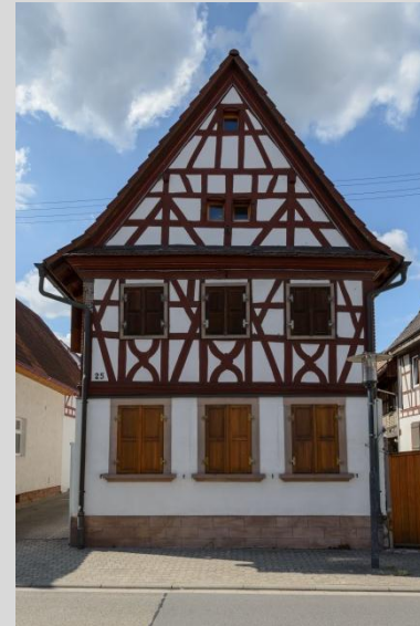
Wohnhaus, Ansicht von Nordosten.
