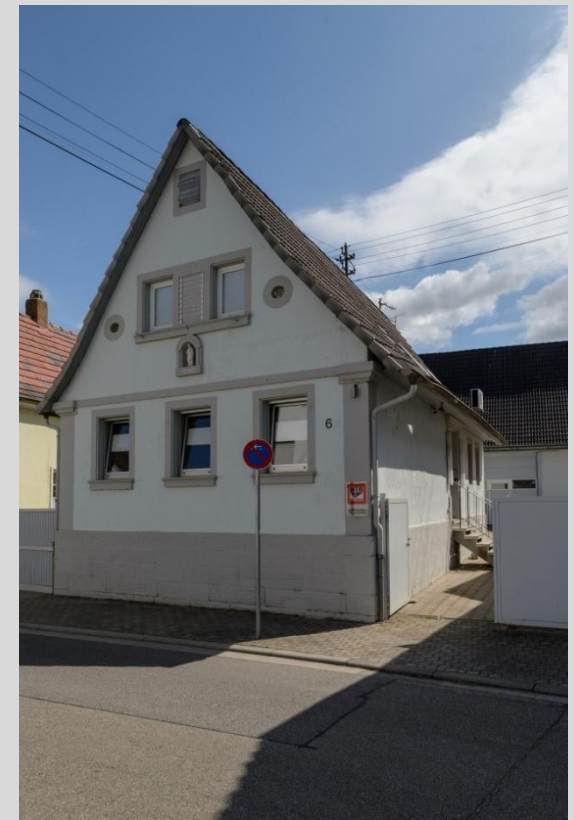
Wohnhaus, Ansicht von Westen.
