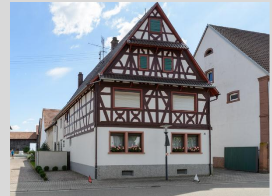
Wohnhaus, Ansicht von Westen.
