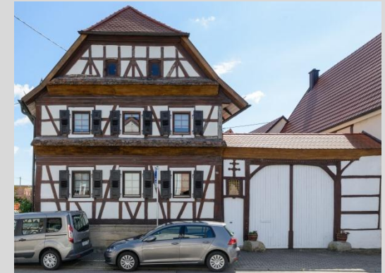
Wohnhaus, Ansicht mit Toranlage.
