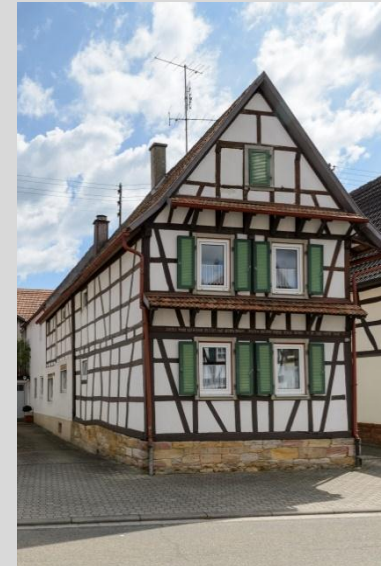
Wohnhaus, Ansicht von Westen.
