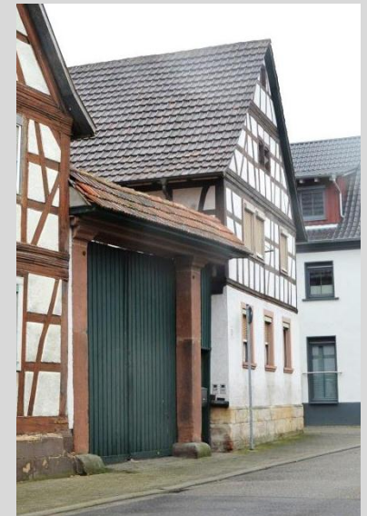
Toranlage, Ansicht von Nordosten.
