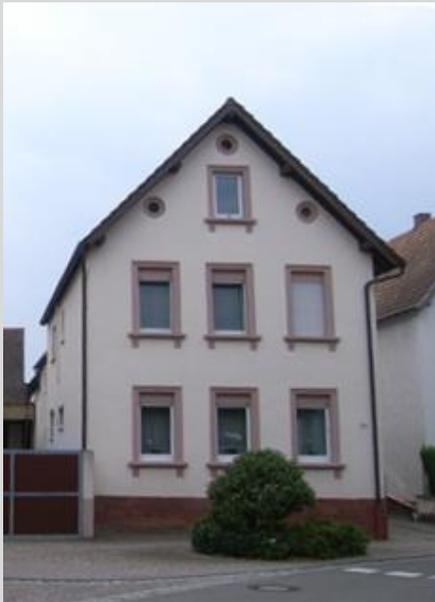
Gebäude, deren Erdgeschoss konventionell gemauert ist, die jedoch im Obergeschoss in Fachwerkbauweise ausgeführt sind. Das Erdgeschoss dieses Gebäudetyps ist glatt verputzt, der Sockel kann ebenfalls verputzt oder in Sandstein ausgeführt sein.
