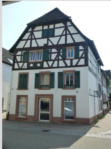
Fachwerkhäuser mit durchgängiger Fachwerkkonstruktion. Hier ist lediglich der Sockel des Gebäudes im Material abgesetzt.
