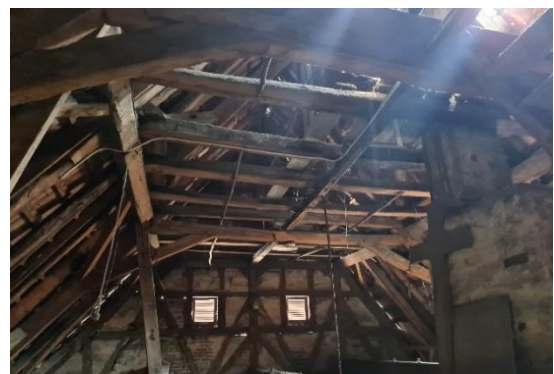
Dachstuhl Untere Hauptstraße 128
