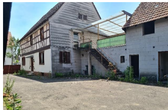
Innenhofsituation innerhalb des Plangebiets mit Blick auf das Anwesen Untere Hauptstraße 128
