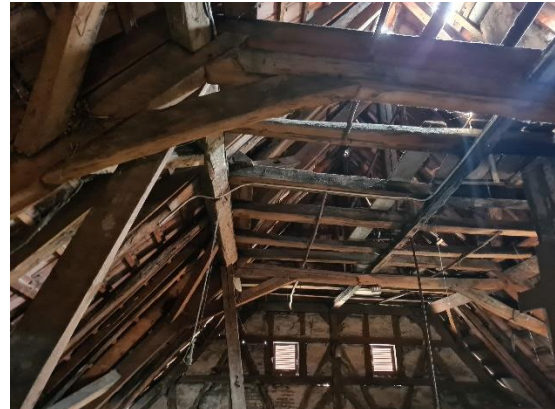
Dachgeschoss des westlichen Wohnhauses
