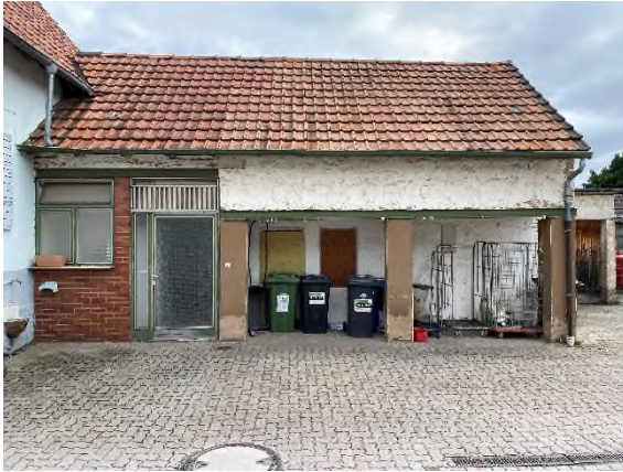
Bild 8: Nebengebäude– Ansicht Ost
