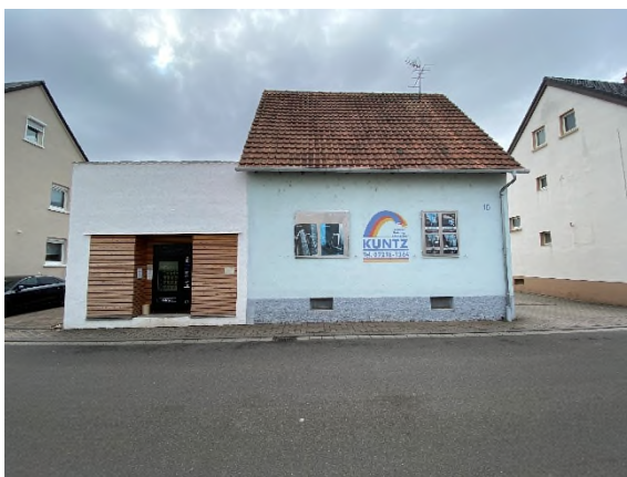
Bild 6: Bestandsgebäude – Ansicht Nord
