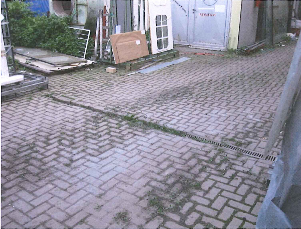
Entwässerungsrinne auf dem Gelände des Gewerbebetriebs am nördlichen Ende des Wegs
