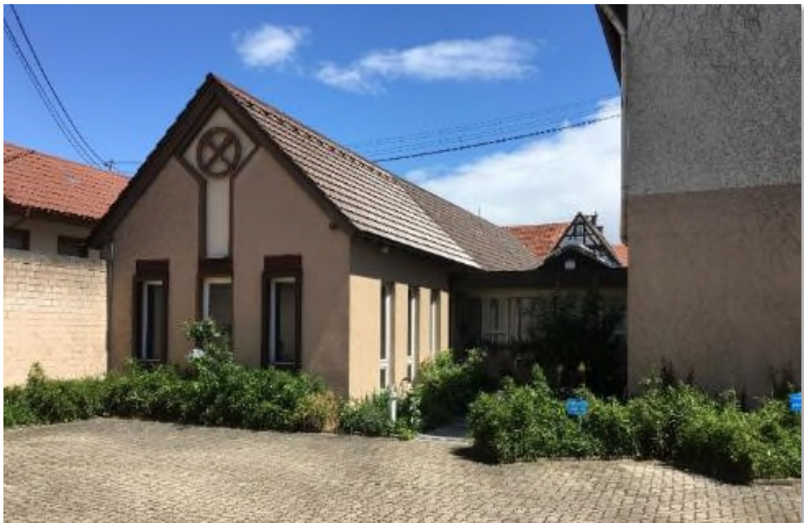
Bild 8: Blick auf den Anbau der Raiffeisenbank westlich des Lagers
