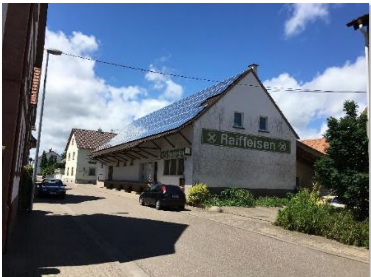
Bild 5: Blick von Südosten
