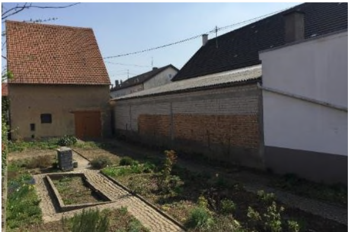
Bild 9: Blick auf das angrenzende Nebengebäude mit Hausgarten
