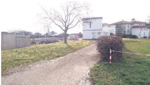
Blick auf das bereits vorhandene Versorgungshaus (02/2021)
