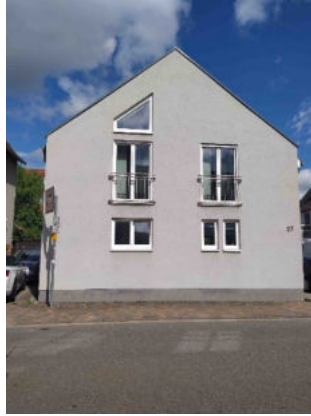
Abbildung 39: Sehr gute Bausubstanz (Holzgasse 27)
