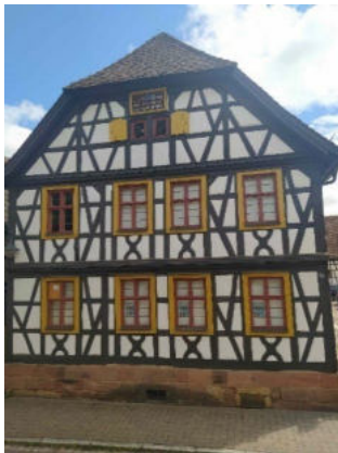
Abbildung 37: Sehr gute Baugestaltung Untere Hauptstraße 153 (Einzeldenkmal)
