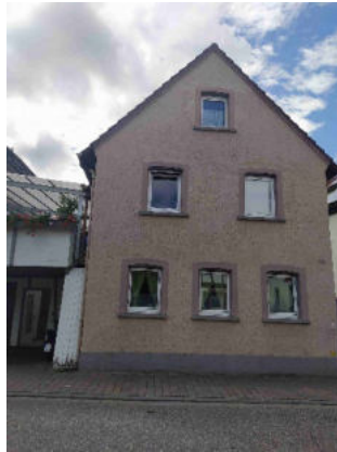
Abbildung 41: Äußere Bausubstanz mit Mängeln im Detail (Speiertsgasse 24)
