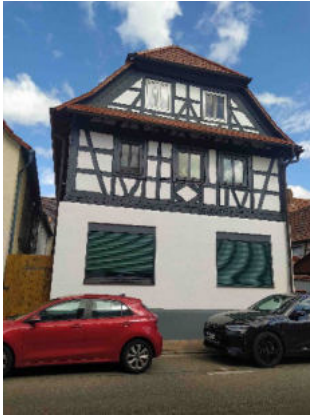
Abbildung 38: Baugestaltung mit Mängeln im Detail (Holzgasse 9)
