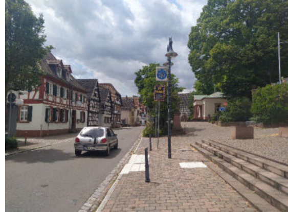
Abbildung 16: Barriere Stützmauer Untere Hauptstr.
