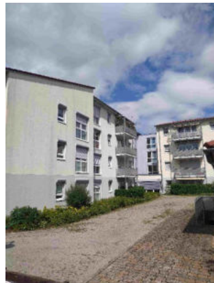
Abbildung 23: Wohnnutzung Untere Hauptstraße 155
