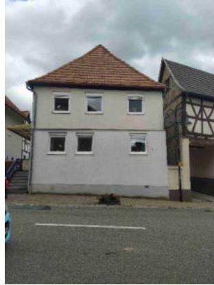
Abbildung 39: Grundlegende Mängel im Gesamterscheinungsbild (Oberhohlstr. 1)
