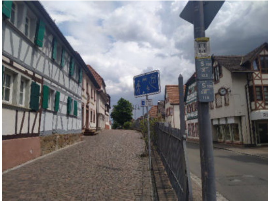
Abbildung 15: Stützmauer Kirchberg/ Niederhohlstr.
