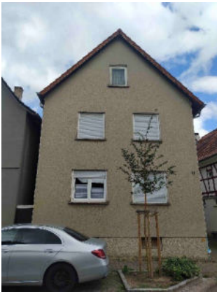
Abbildung 42: Gute äußere Bausubstanz (Lehrgasse 11)
