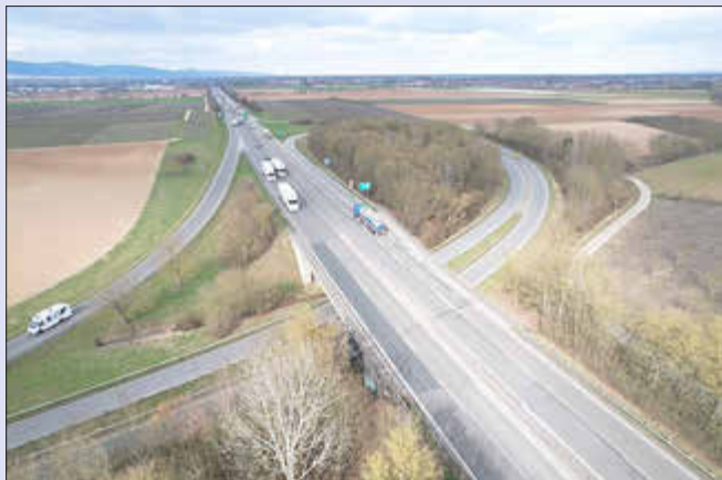
Autobahnbrücke über die B38 im Bereich der A65-Anschlussstelle Landau-Süd. Quelle: Autobahn GmbH Niederlassung Südwest
