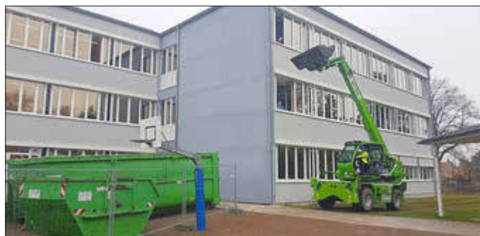
Die Sanierungsarbeiten am PAMINA-Schulzentrum in Herxheim haben begonnen.
